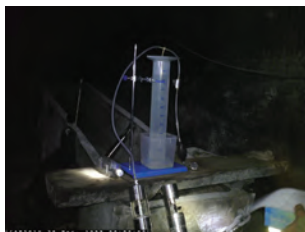
Рис. 1. Установка для измерения выделяющегося газа V_1 в шахте
